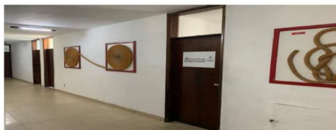
Corredor de acesso às salas
